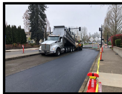
Pave new asphalt.
